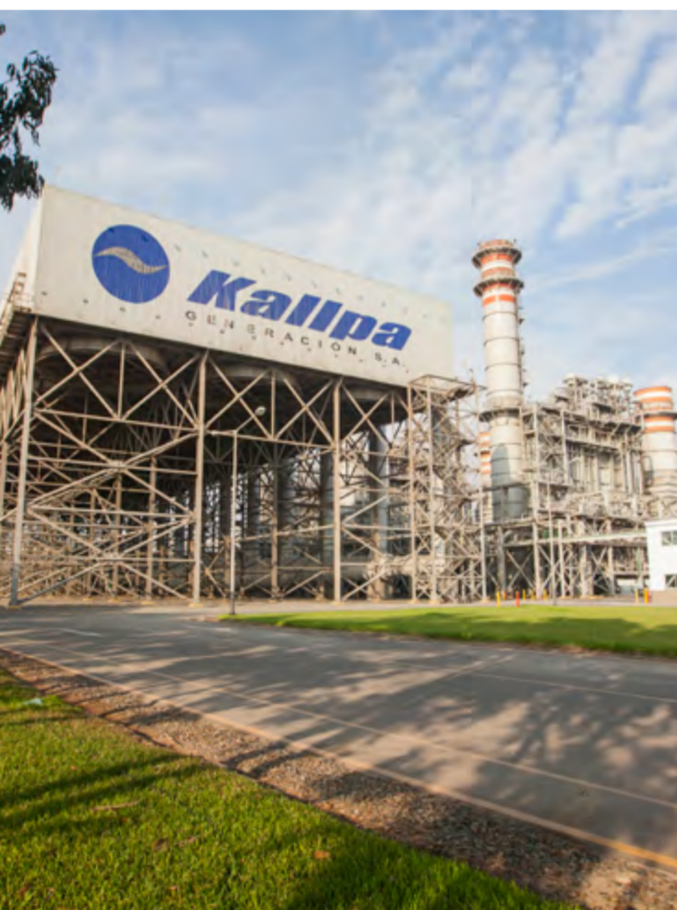
CENTRAL TÉRMICA KALLPA.
