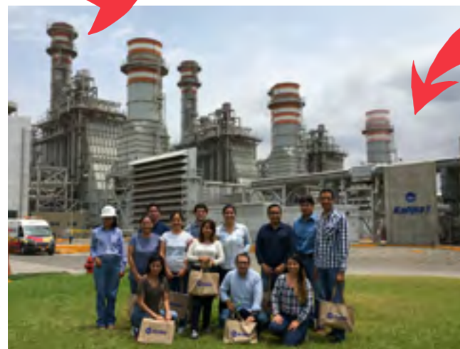
VISITA A LA CENTRAL TÉRMICA KALLPA.
